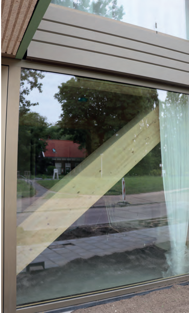
De diagonalen van het skelet lopen soms voor ramen langs, maar nooit meer dan één raam per appartement.
